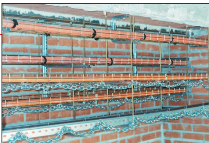
figura 1. Vista general del montaje
