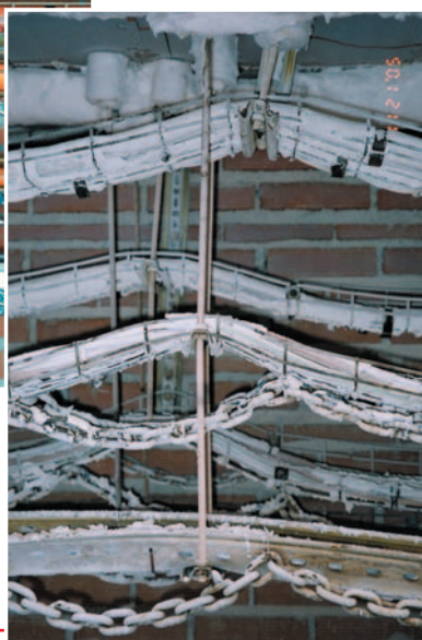
figura 3. Estado final tras superar el ensayo
